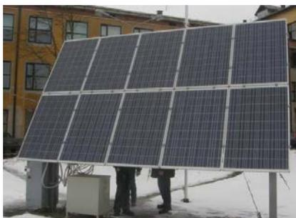
**Figure 2.** Two kilowatts PV array of 10 Kioto KPV 195 PE modules.
